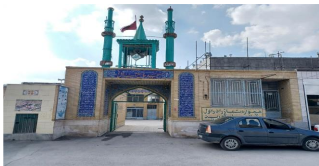
زیرو سازی و اجرای ایزوگام پشت بام مسجد آبنیل ( ۶۵۰ مترمربع )
