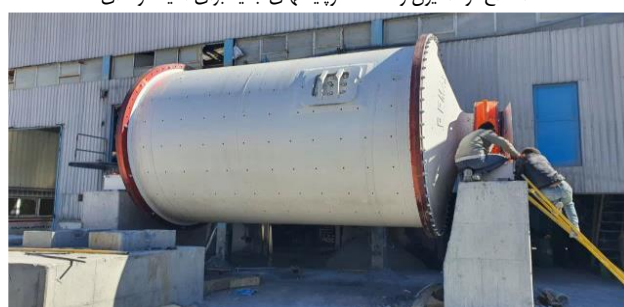
نصب بال میل ۱۰۰۰ تنی کارخانه گوسفیل
