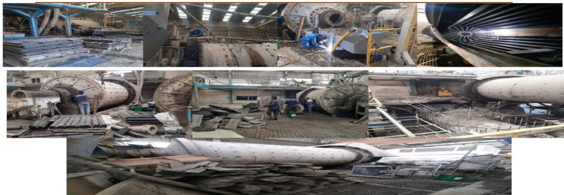
آماده سازی، تعمیر و نصب تجهیزات خردایش سنگ شکن کارخانجات کلاهدروازه، گوشفیل و آزمایشگاه
