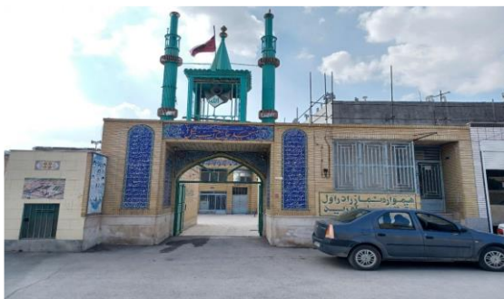
زیرسازی و اجرای ایزوگام پشت بام مسجد آبنیل (۶۵۰ مترمربع)
