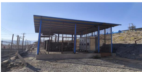
نصب و راه اندازی دو دستگاه دیزل ژنراتور ۶۰۰ KVA
