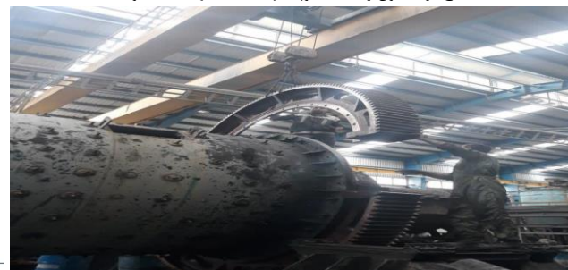
تعمیر لنگر فکی سنگ شکن کارخانه گوشفیل
